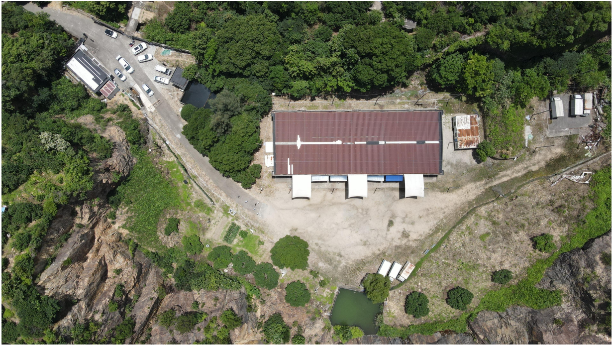
现场勘察时的库区航拍图
